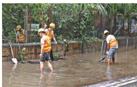
■渠務署派員清理淤塞渠道。
