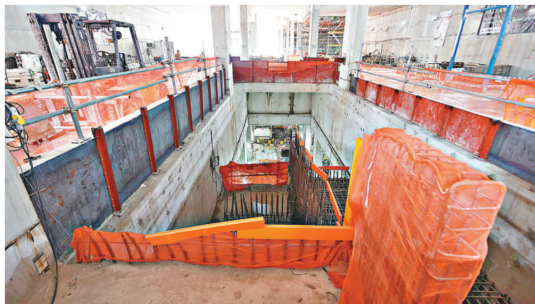
■大堂層將建扶手电梯到月台層，周圍已擺放預製組件。
