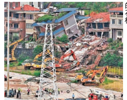
挖機開始挖開覆蓋在廢墟上的石板。
