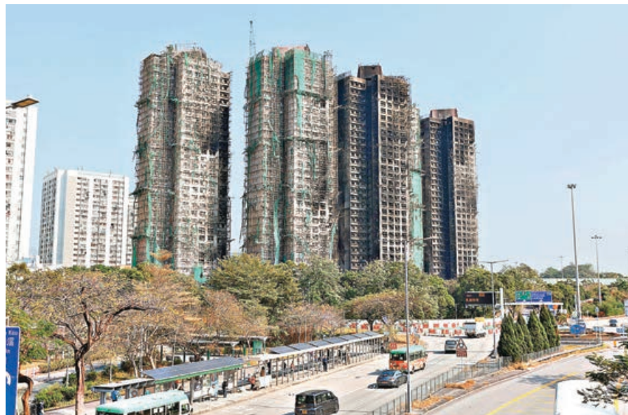
■ 宏福苑火災後，現場一片頹垣敗瓦。
