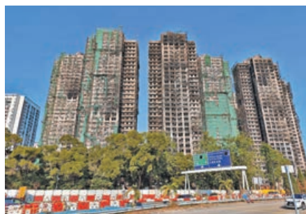
宏福苑火災後，現場一片頹垣敗瓦。
