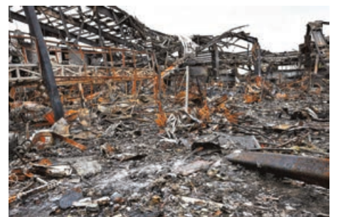
德黑蘭一間修車廠遭以色列襲擊，變成一片廢墟。路透社
