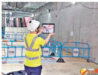
港鐵職員以AR技術巡查工地。
