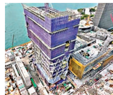
■ 演藝中心和藝術大樓仍在施工中。官方圖片
