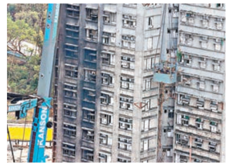
■工人為宏福苑進行加固工程。資料圖片
