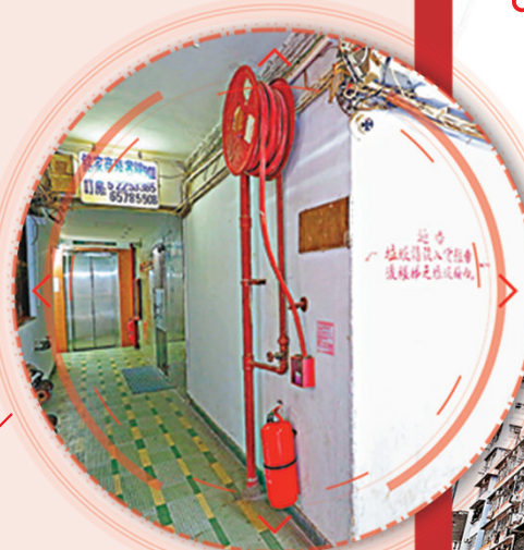
舊式樓宇設有消防喉轆及警鐘等設備。 資料圖片
