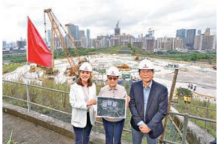
沙嶺數據園區已開始動工。
