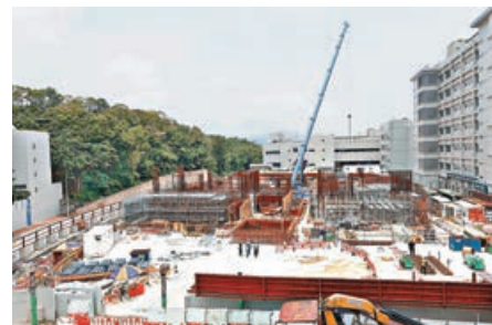
■醫學教研綜合大樓動工中。
