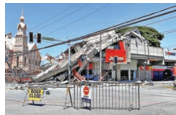
桑托斯將軍城一棟建築物在地震中倒塌，附近道路被封鎖。
