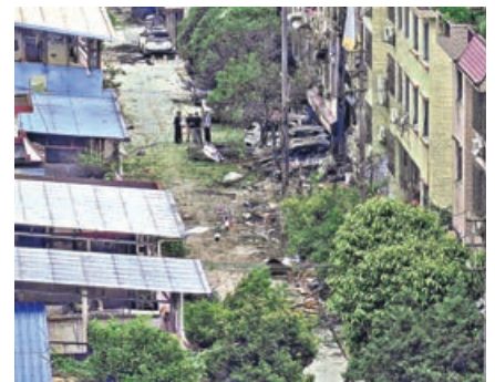
■爆炸現場設施受損嚴重，一片狼藉。
