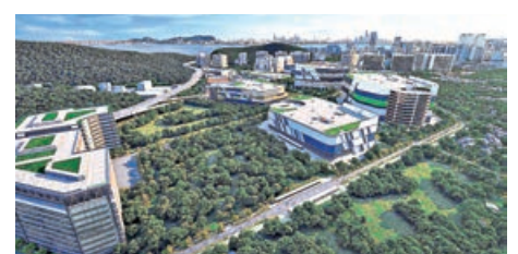
洪水橋將發展成北都區跨境物流樞紐。
