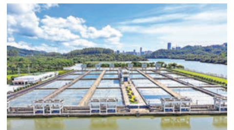
■深圳水庫的生物硝化站，為供港東江水過濾、淨化。
