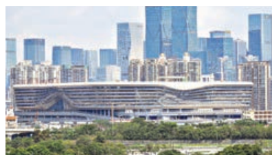
■新皇崗口岸聯檢大樓工程接近尾聲。
