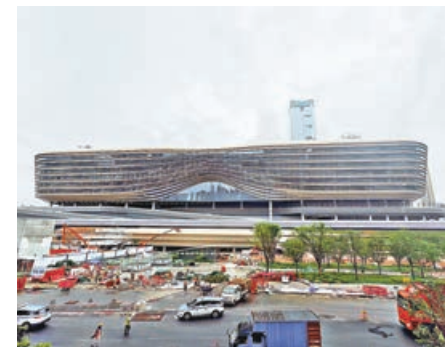
■新皇崗口岸聯檢大樓已基本完工。
