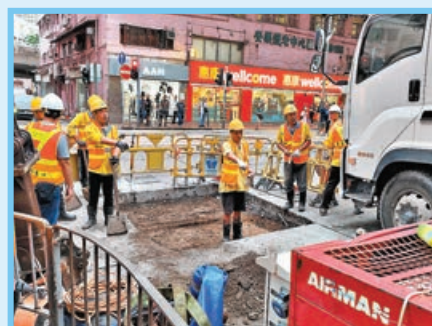
■工程團隊鎖定漏點，並展開挖掘工作。
