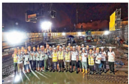
■5號及6號大樓昨日同時平頂。 港深創科園供圖
