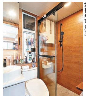
■廁所牆身鋪木紋磚，配黑色鋁質窄邊框玻璃浴屏。
