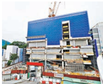
■建設中的醫學大樓已經平頂。
