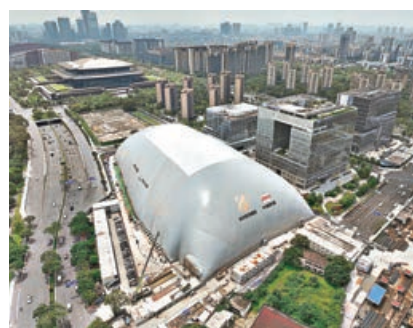
■巨型「充氣枕頭」——基坑氣膜設施。
