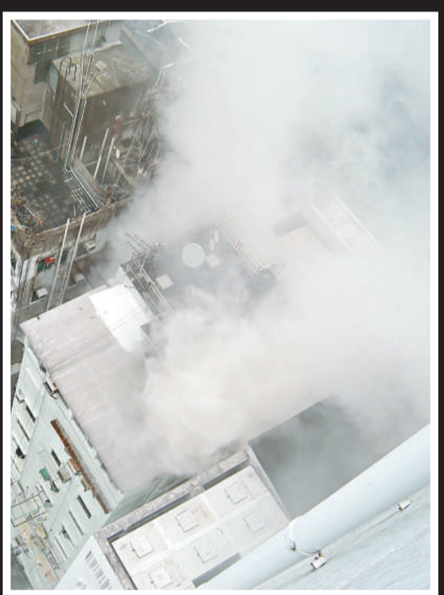
煙囪效應，濃煙直沖上頂
