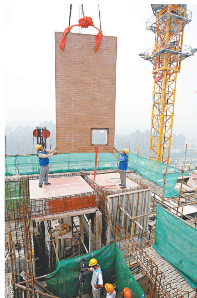
8月14日，上海一裝配式住宅樓正在吊裝最後一塊PC構件。此類組裝式樓房被稱為「新型綠色環保節能建築」
