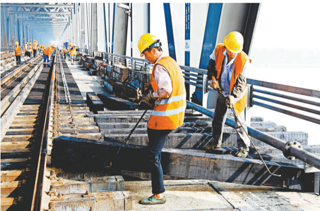
長江鐵路橋更換橋枕 九江長江大橋為雙層雙線鐵路、公路兩用橋，於上世紀90年代初建成通車，經過多年的風雨侵襲，大橋部分鐵路橋枕老化嚴重。自上月開始，南昌鐵路局對鐵路橋下行橋面進行噴砂除鏽、噴鋁防鏽和更換橋枕。據悉，此次大橋將更換橋枕1300餘根，預計10月底全面完成。圖為施工人員在鐵路橋上更換橋枕。(新華社)
