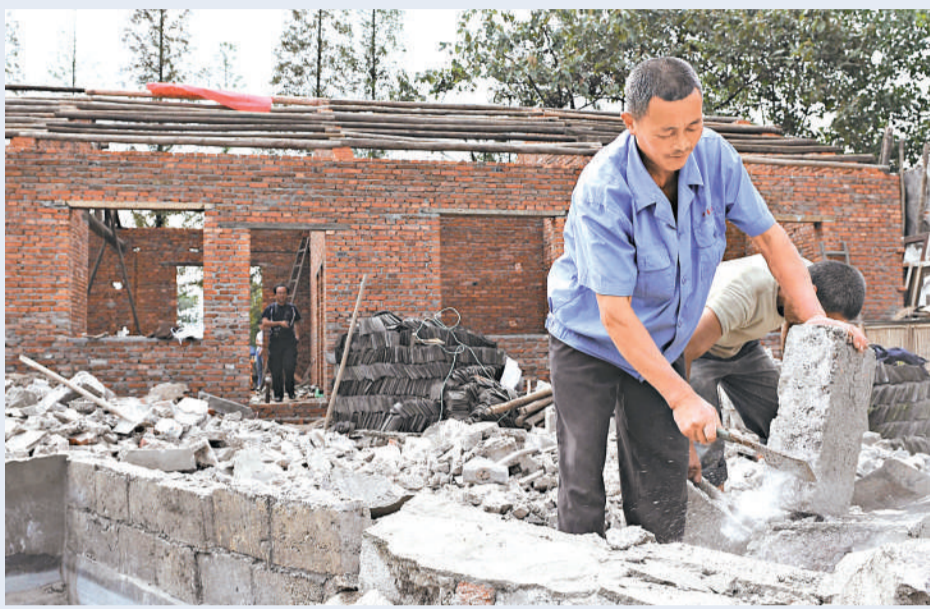
綿竹災區農民建新房 四川省綿竹市一些條件較好的地震受災家庭，不等政府「資援」已進行房屋的重建和維修工作。圖為工人10日在綿竹市西南鎮一農家修建的新房前整理磚塊。(新華社)
