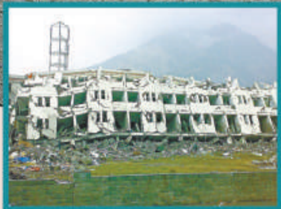
地震波令地底岩石向上湧出，漩口中學的地層稍軟，整個地基被抬起
