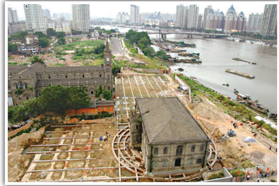
▲泛船浦教堂「神父樓」在向東平移約七十多米後，成功實現整體九十度逆時針轉身 (鄭祚聲攝)
