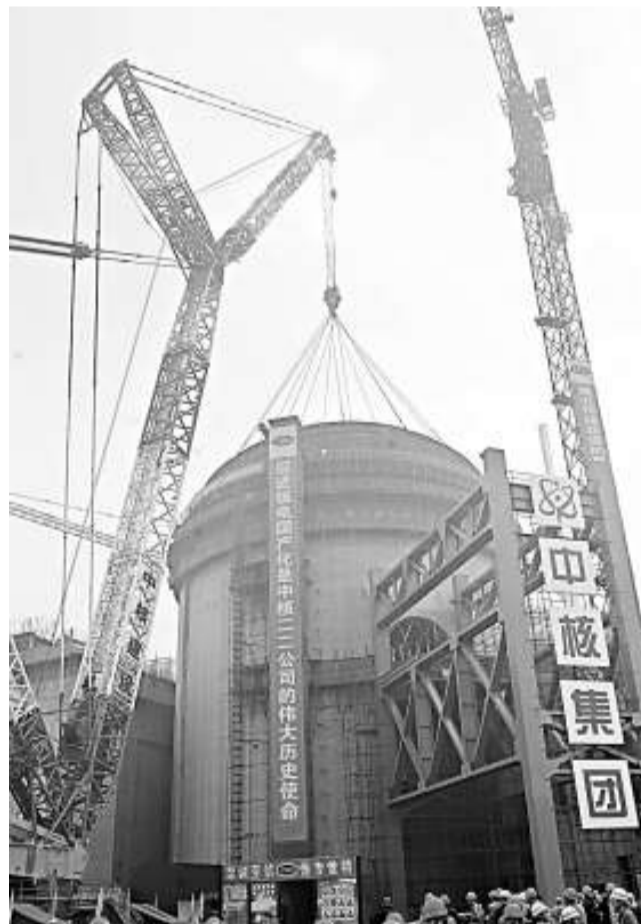
六日，位於浙江省海鹽縣的中核集團秦山核電二期擴建工程4號機組反應堆廠房安全殼穹頂一次性整體吊裝成功，標誌着我國「十一五」期間首個開工的核電工程兩台機組結束土建，全面轉入安裝階段。（新華社）
