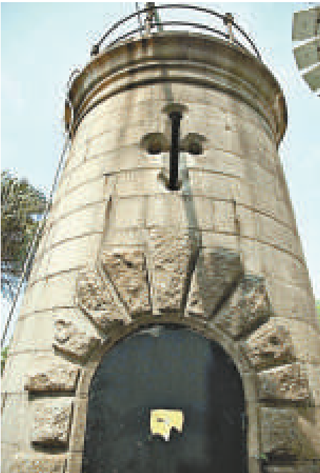
舊青洲燈塔門口沿邊飾以凸出的粗面隅石，牆上有「十」字開口
