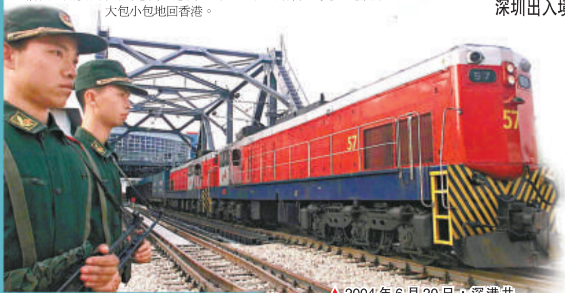
▲2004年6月20日，深港共建的羅湖鐵路新橋竣工
