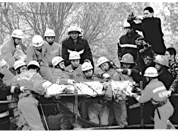
救援人員16日上午在地鐵工地塌陷處發現一具遇難者屍體。（中新社）
