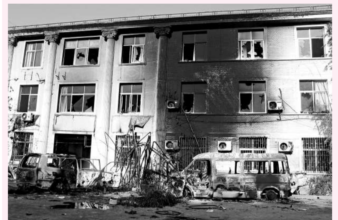
甘肅省隴南市17日發生的上訪人員打砸事件，到18日凌晨，部分上訪人員衝擊市委機關，砸壞部分車輛和辦公設施。圖為遭暴徒焚燒後留下的痕跡仍清晰可見 (中通訊)
