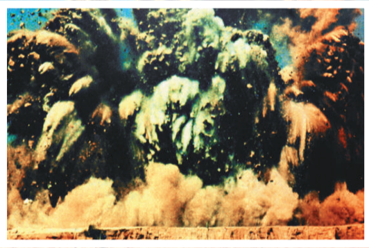
◀ 1979年，蛇口工業區基礎工程破土動工
