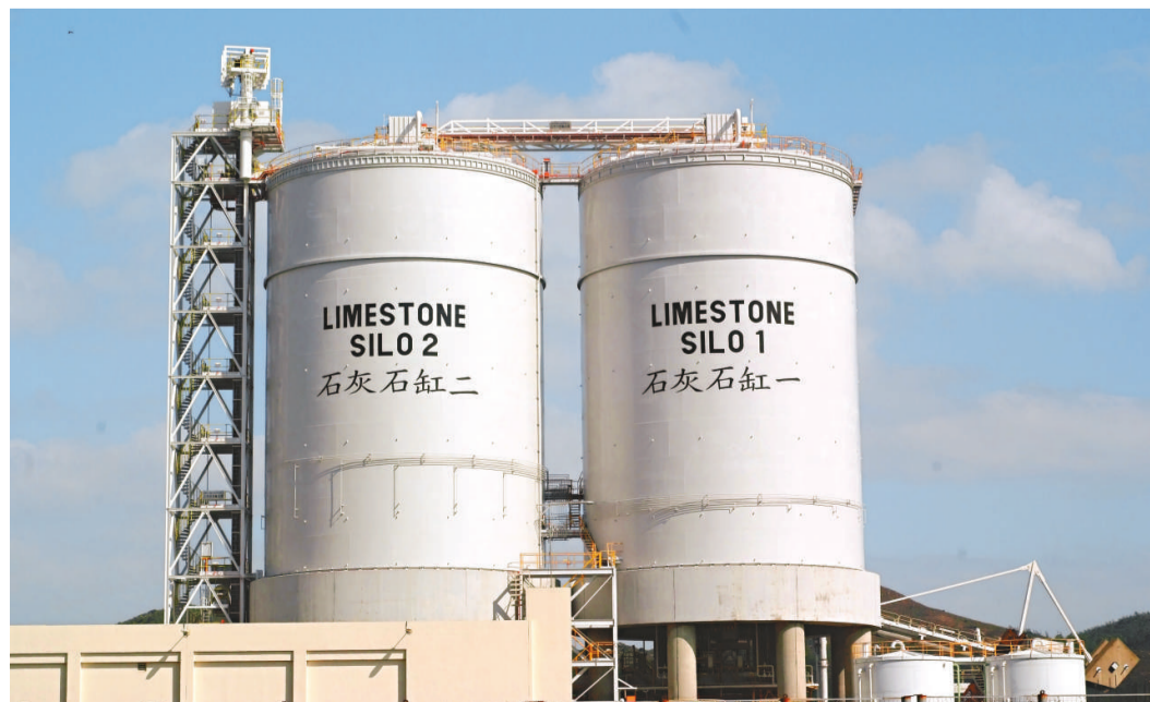
▲煙氣脫硫裝置是南丫發電廠的重要減排設施，該系統利用石灰石／石膏濕潤式洗處理，將燃煤發電的煙氣中九成以上的二氧化硫吸走。脫硫過程產生的石膏，經過濾後會儲起，再運到本港或外地作工業用途 (官漢傑攝)
