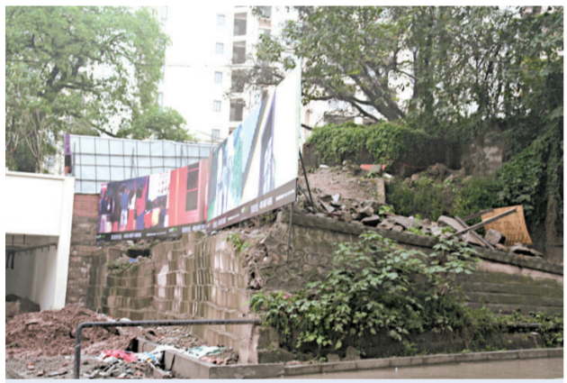
尚未完工的小區圍牆，左下角爲仍遭遺頭堵塞的停車場入口（本報實習記者 陳曉彬攝）
