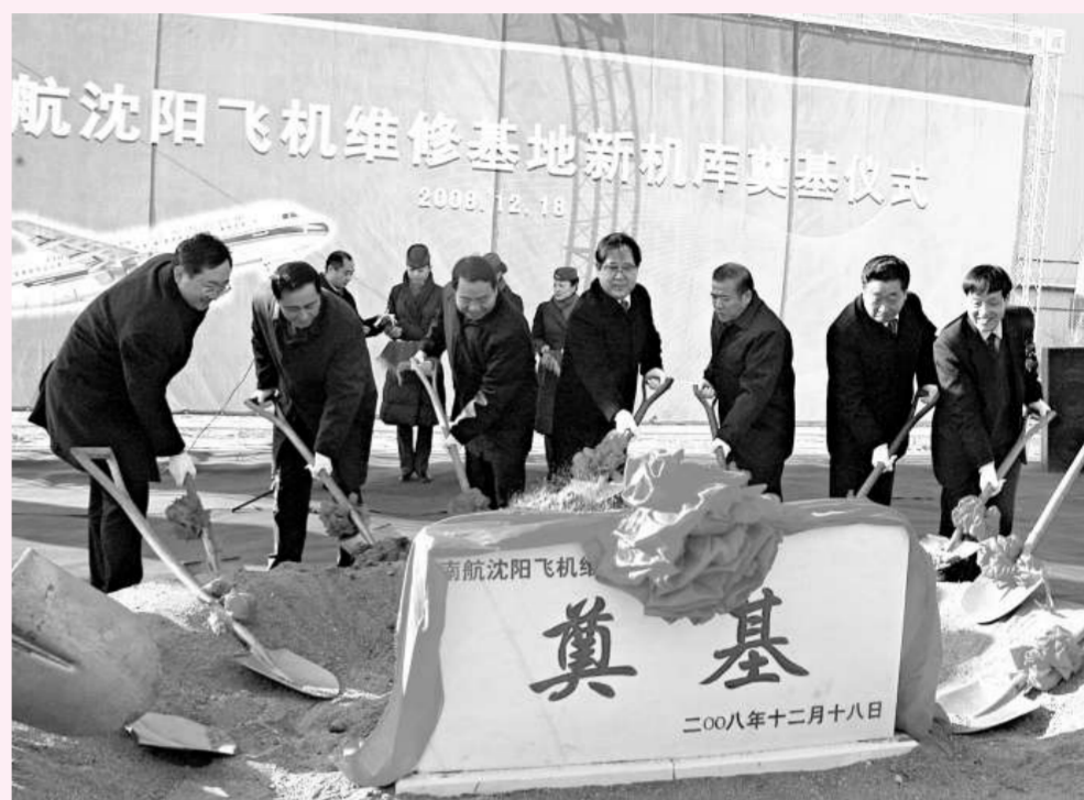
南航瀋陽飛機維修基地舉行奠基儀式，2010年完工並交付使用（本報攝）
