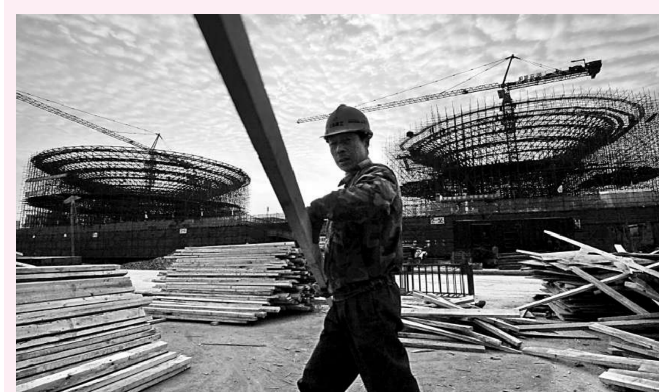
滬封頂 12月22日，施工人員在「陽光谷」建設工地拆除施工附屬支架。當日，上海世博會世博軸4號「陽光谷」結構封頂。世博軸工程是2010年上海世博會園區的中央交通景觀軸線，為上海世博會永久性建築之一 (新華社)
