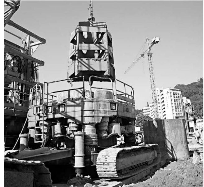
房署在東頭平房西區公屋地盤採用三百六十度磨樁機，減少打樁震動，避免損壞毗鄰的一級歷史建築物侯王廟
