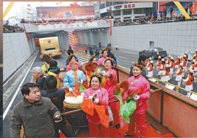
▲建設單位的車輛敲鑼打鼓從通車的隧道通過 (新華社)
