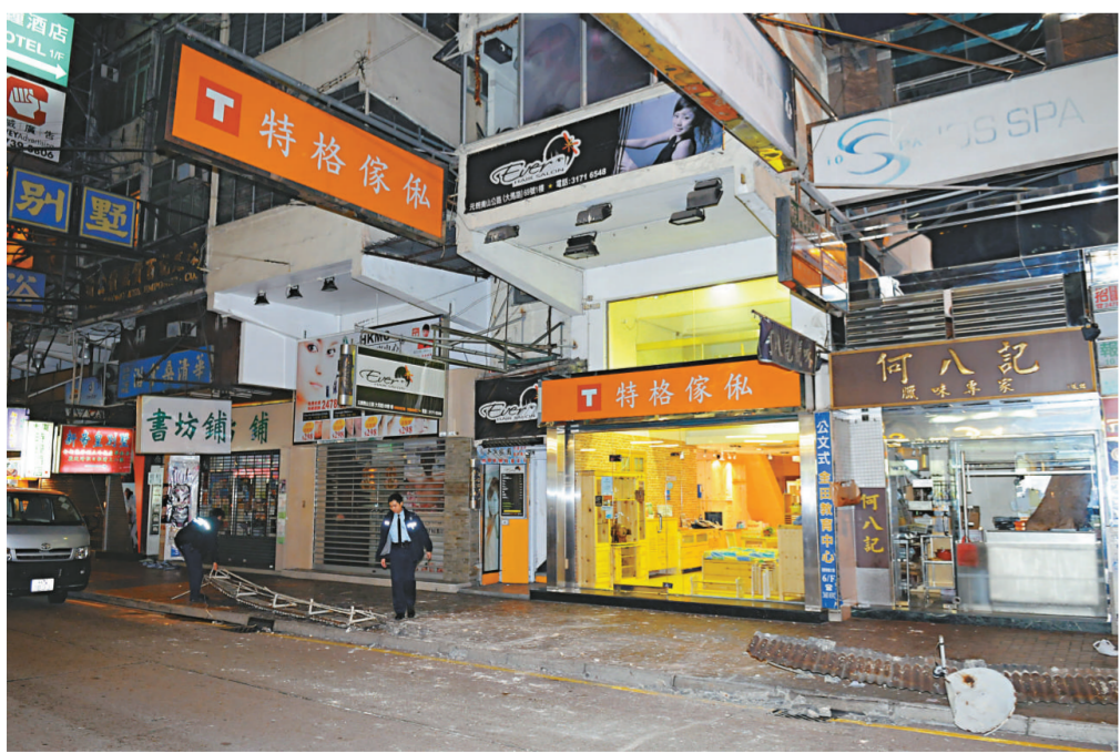
▲元朗唐樓簷篷倒塌現場
