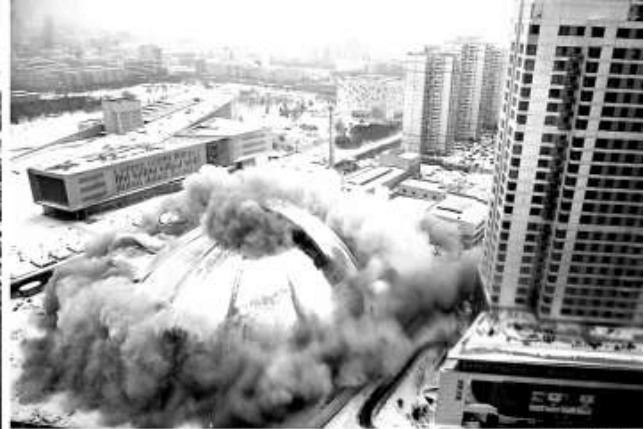
瀋陽「夏宮」被爆破拆除過程
