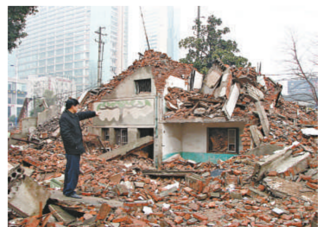
袁耀華站在被強行拆除的房屋面前欲哭無淚
