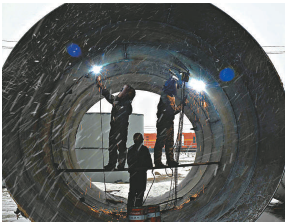
▲在河北唐山的首鋼唐山公司鋼鐵廠建設工地，工人冒雪施工。該廠全部工程計劃於2010年投產 (新華社)
