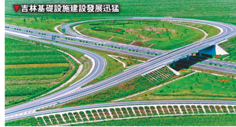
▲吉林基礎設施建設發展迅速
