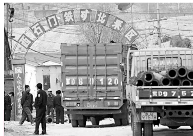
河北邯鄲礦山局西石門鐵礦29日突發冒水事故，8人被困。圖為西石門鐵礦
