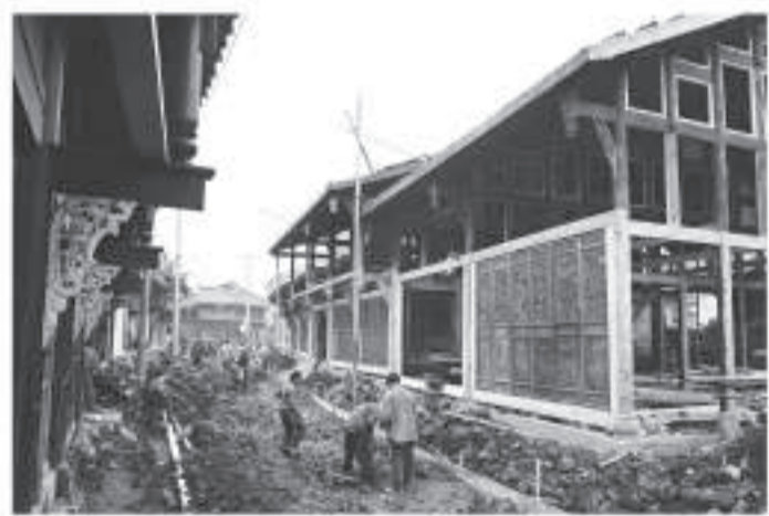
▶建築工人正修建水磨鎮老街 (盛北星攝)
