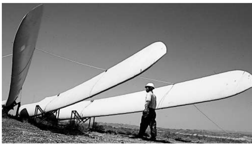
國電新疆阿拉山口風電場總體規劃裝機容量1千兆瓦，分四期建設。目前一期工程正在建設，預計10月底竣工投產。圖為一名工程技術人員從風車葉輪旁走過。
