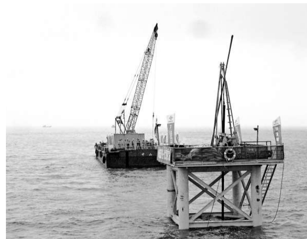
港珠澳大橋主體工程初步設計勘察近日提早完成，為大橋加快於十一月完成初步設計、今年底前動工建設奠定基礎（本報攝）
